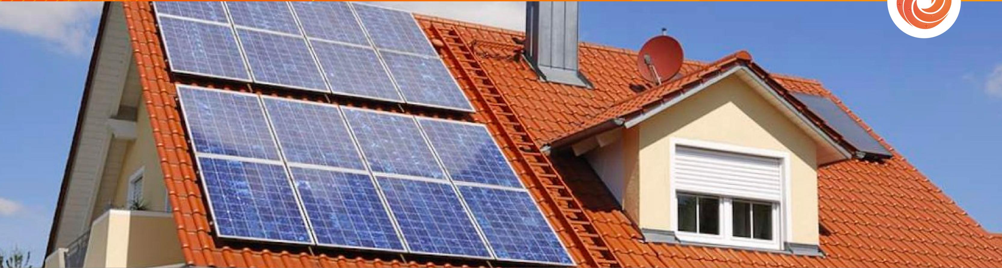
Nuestros **sistemas de ahorro energético**, compuestos por paneles solares e inversor de corriente **On Grid**, se encargan de transformar la radiación solar en energía eléctrica. La misma es volcada a la vivienda, comercio o industria, generando así un **ahorro de hasta 60% del consumo energético**, que se verá reflejado en la factura mensual.
