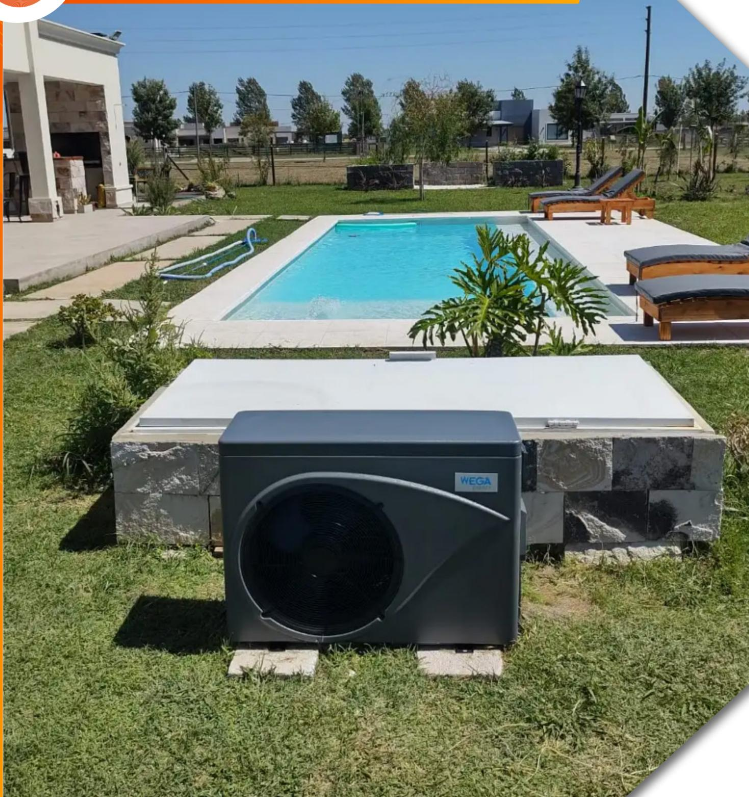
El **dimensionamiento de una bomba de calor** para piscina se basa principalmente en el volumen ( $m^3$ ) de la piscina a calefaccionar.
